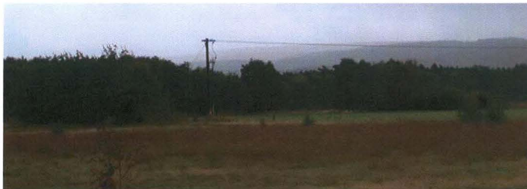
Befintlig 20-kilovoltsledning som korsar detaljplaneområdet.
